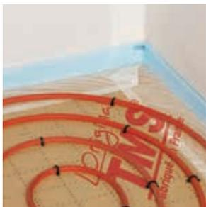
L'isolation thermique des sols permet à la fois de réduire les déperditions des planchers (autour de 10 % des pertes d'un logement) mais aussi de limiter les ponts thermiques liés aux liaisons périphériques et surfaciques (10 % également).
