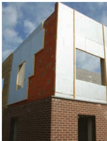
Dans le cas de bardage à joints ouverts en ITE, la pose d'un pare-pluie **Soplutec® UV** est nécessaire.
