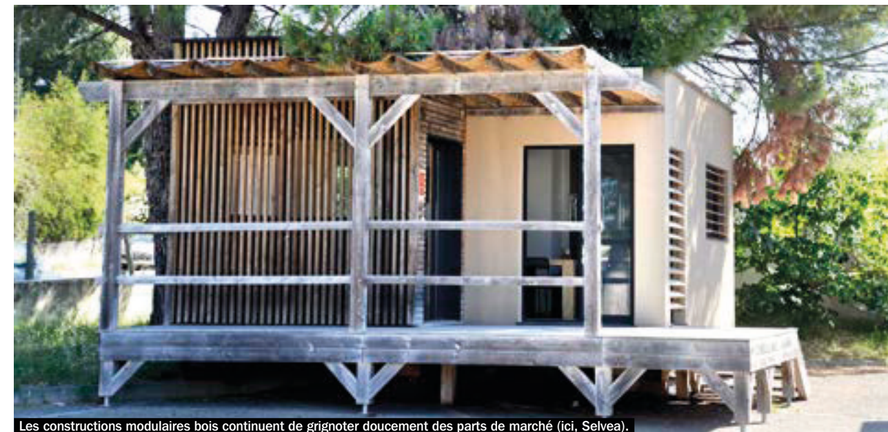
Les constructions modulaires bois continuent de grignoter doucement des parts de marché (ici, Selvea).
